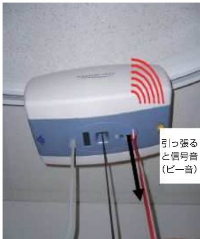
赤いコードを下に引っ張り電源を遮断
