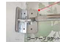
突っ張り棒接着固定
