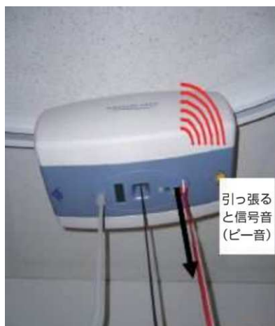
赤いコードを下に引っ張り電源を遮断
